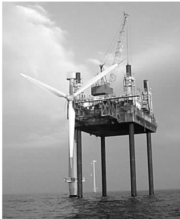
Abbildung 3: Die SEACORE Jack-up Plattform wurde zum Bohren und für die Errichtung der Anlagen verwendet
